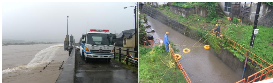
排水ポンプ車出動状況 (R2. 7豪雨 横山第二排水樋管)
